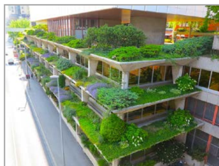
Fig94 : Toiture végétale extensive
