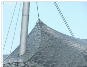
Fig 83:Couverture à membrane tendue par câbles d'acier
