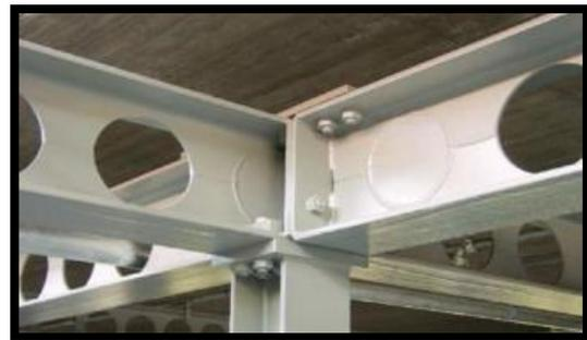
Figure 125 : assemblage poteau poutre métallique
