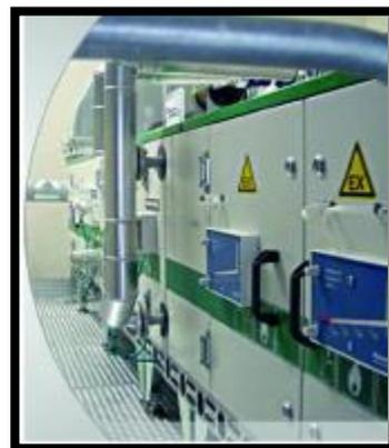
Figure 135 : centrale de conditionnement d'air
