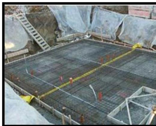
Figure 113 : ferrailage d'un radier général
