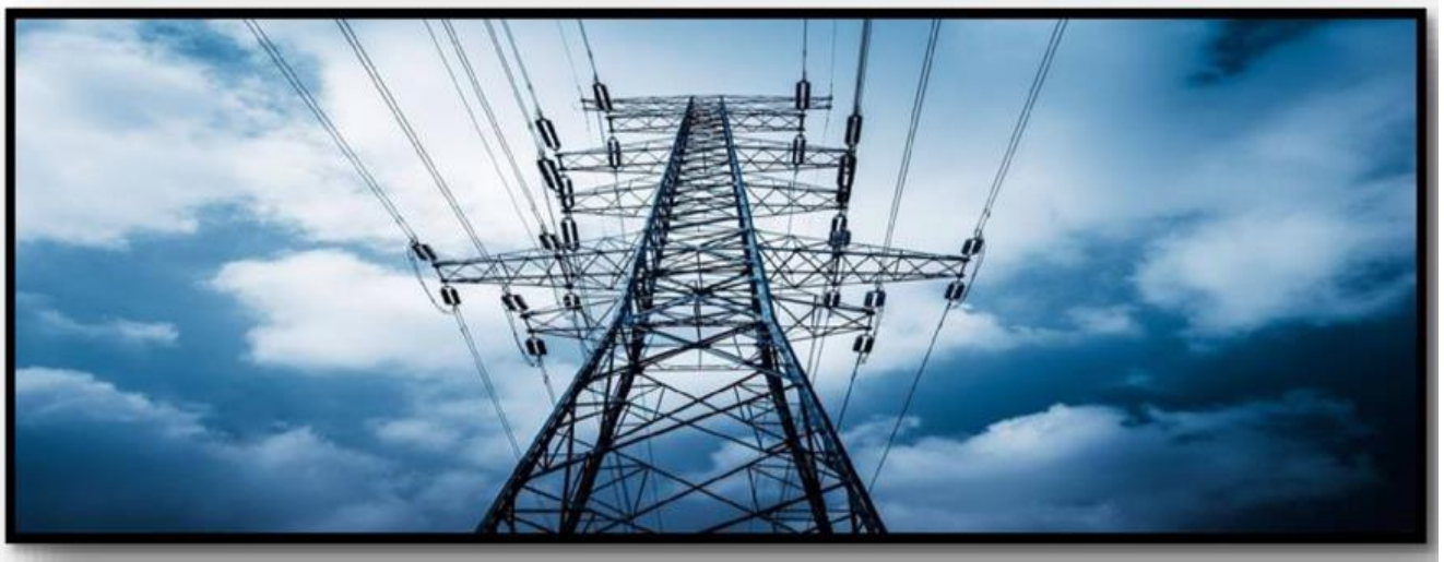
Figure (I-16) : Ligne électrique à haute tension (aérienne). [8]
