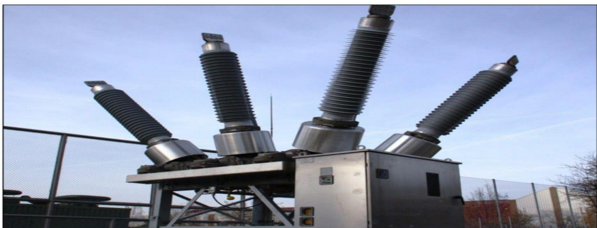
Figure (I-11) : Disjoncteur SF6. [7]
