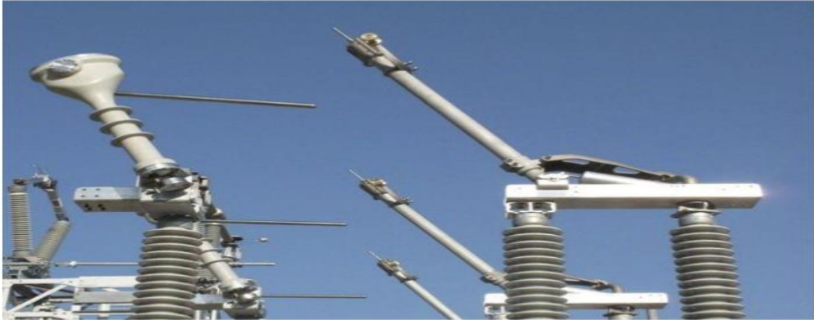
Figure (I-12) : Sectionneur HT. [7]
