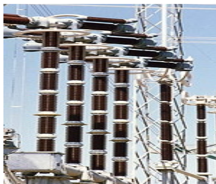
Figure II-14: Disjoncteur à air comprimé
