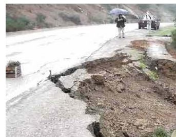
Figure 15. Exemple de mouvements de masse menaçant les voies de circulation
