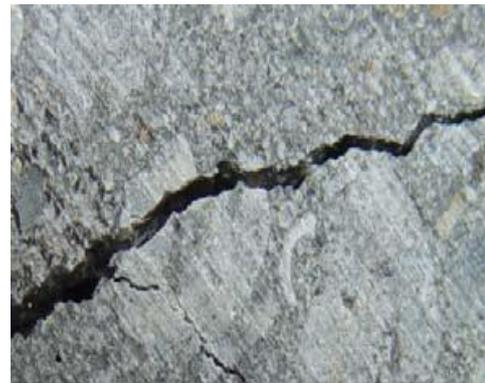
Figure II. 16 : La fissure traverse les granulats sans armatures transversales
