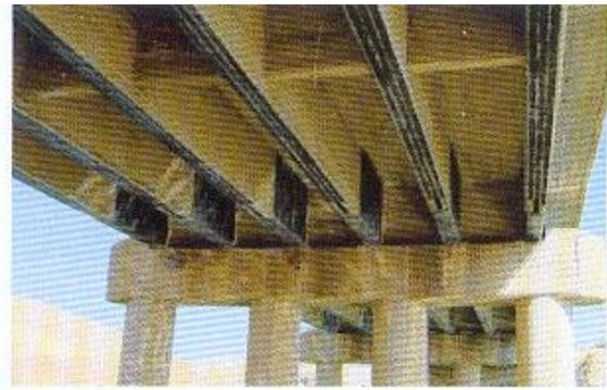
Figure III. 15: Exemple de renforcement des poutres par matériaux composites [54].
