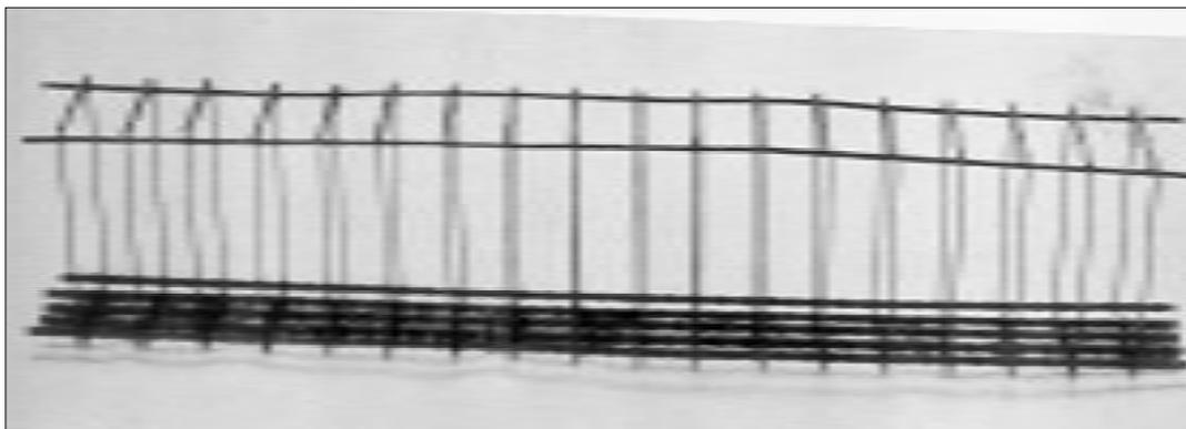
Figure II. 17: Exemple d'armature pour une poutre simple : l'armature longitudinale inférieure a le but de reprendre la flexion, l'armature verticale, sous forme de barres pliées en forme d'étriers, a pour but de reprendre l'effort tranchant alors que les deux barres longitudinales supérieures de faible diamètre servent à tenir les étriers pendant le montage des armatures et la mise en place du béton (armatures constructives).
