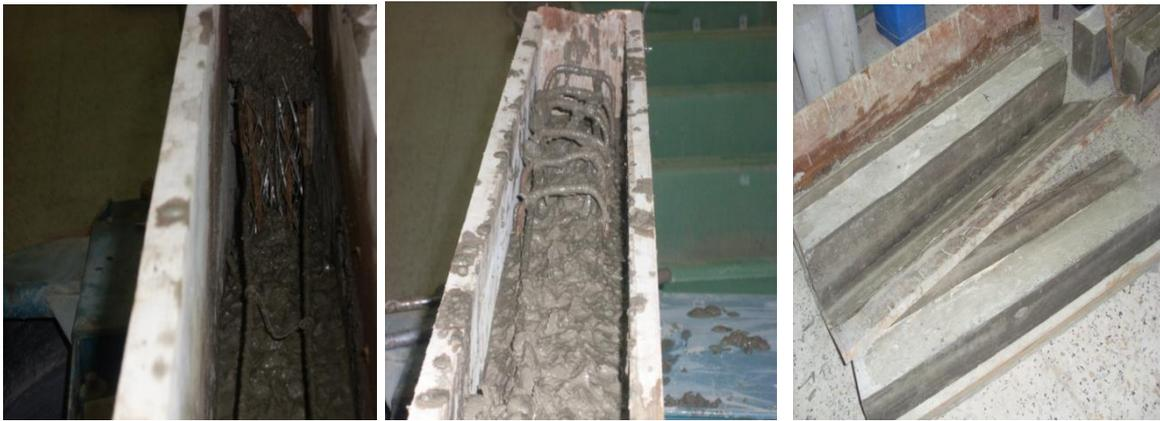
Figure V. 8: Confection, Moulage et Démoulage des poutres.
