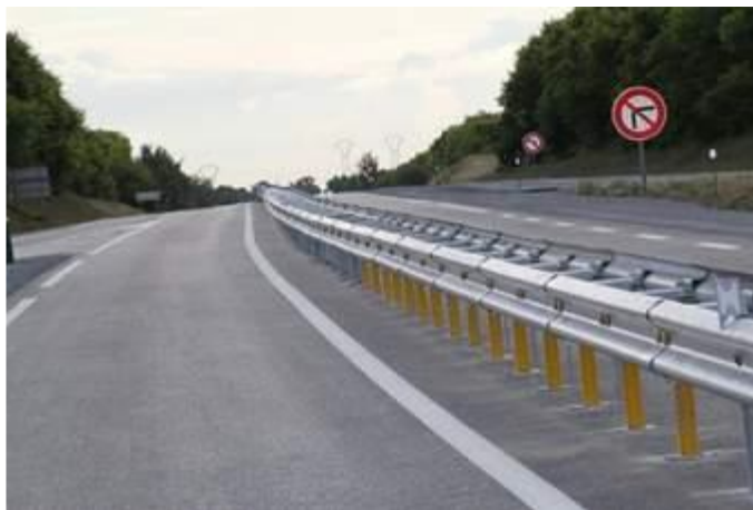
Fig. VIII.9. Les glissières de sécurité
