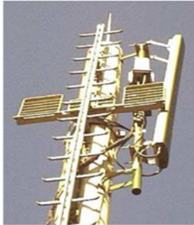
Figure 2.7: Antenne directionnelle avec tilt négatif
