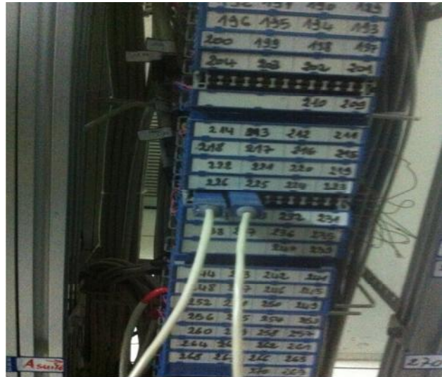
Figure 4.18 : bouclage de la liaison E1
