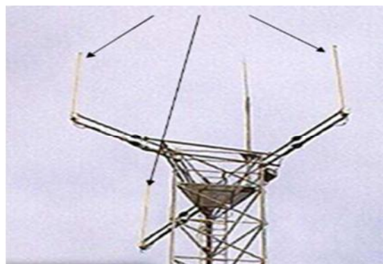
Figure 2.10 : Site monosectorisé avec de la diversité spat
