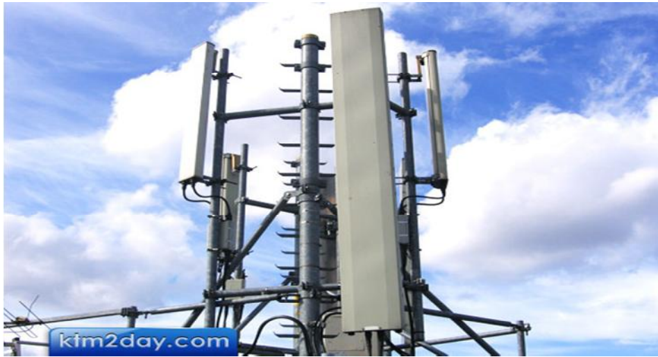
Figure 2.1 : BTS rayonnante avec 6 antenne directionnelle
