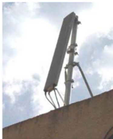
Figure 2.7: Antenne directionnelle avec tilt positif
