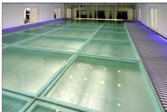
Figure 152: plancher translucide. Source : PDF: Construire en acier.
