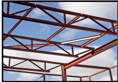
Figure 126: photo d'une poutre treillis.
