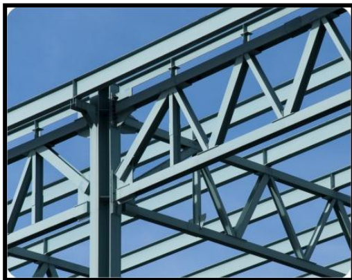
Figure135 : schéma présentatif d'un assemblage poteau-poutre métallique
