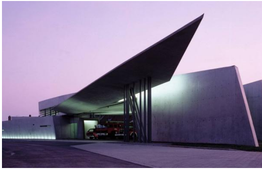
Figure 102 : La caserne des pompiers du campus Vitra. Http://www.slate.fr
