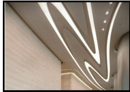
Figure159: faux plafond en plâtre www.placo.ltech-alu.com
