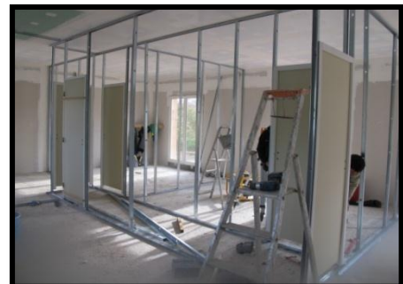
Figure157: système de fixation des cloisons Http // : www. over-blog.com
