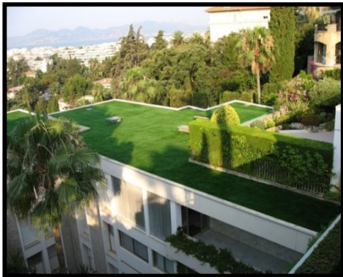
Figure 129 Photo d'un toit jardin http://www.universgazons.com
