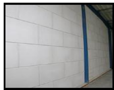
Figure165: mur coupe-feu. http://www.batiweb.com
