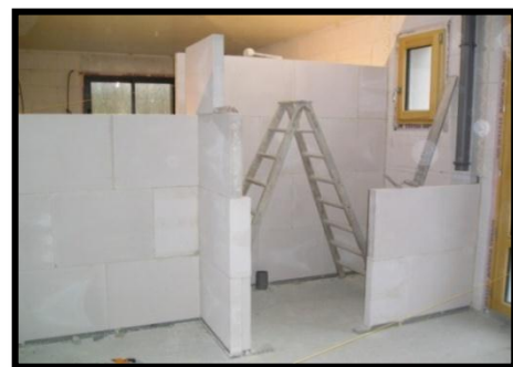
Figure 158 : cloisons en siporex http//www.storage.canalblog.com
