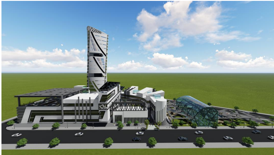
Figure 110 : La façade donnant sur la rue Hassiba BENBOUALI
