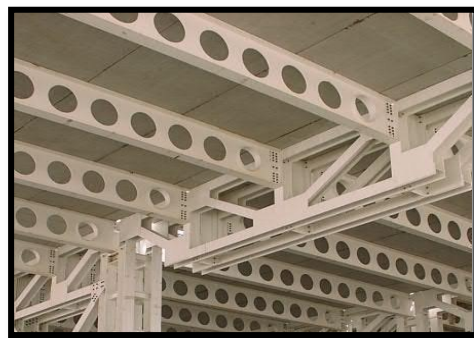
Figure127: photo d'une poutre alvéolaire.
