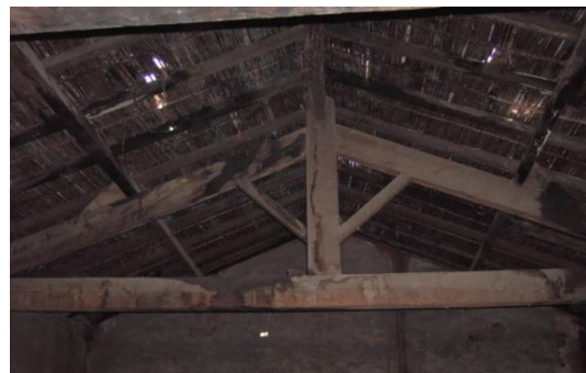
Fig.14 : système constructif en bois de la maison Kabyle
