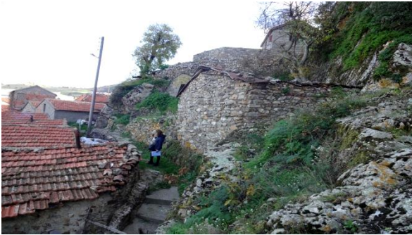
Fig76 : Parfaite intégration au site
