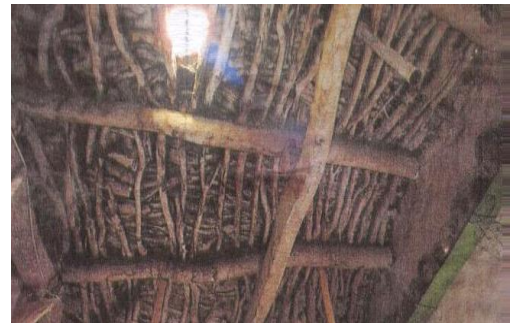
Fig.22 : toit d'une maison Kabyle
