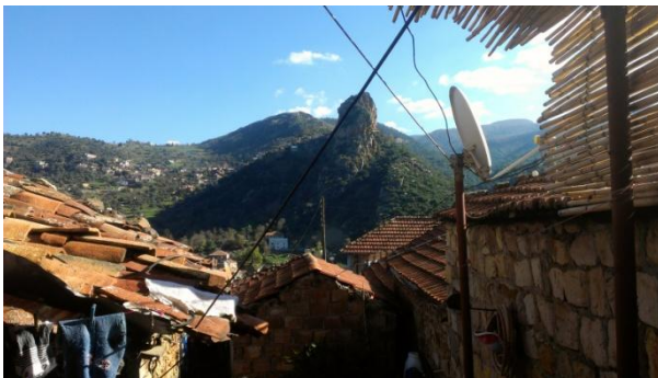
Fig74 : Usage des matériaux locaux (village Ait Yahia)
