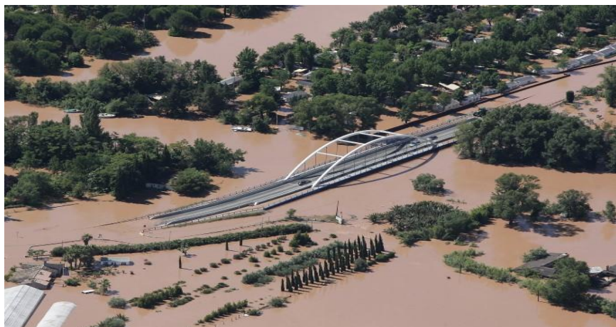
Figure 1.5 : Inondation en inde
