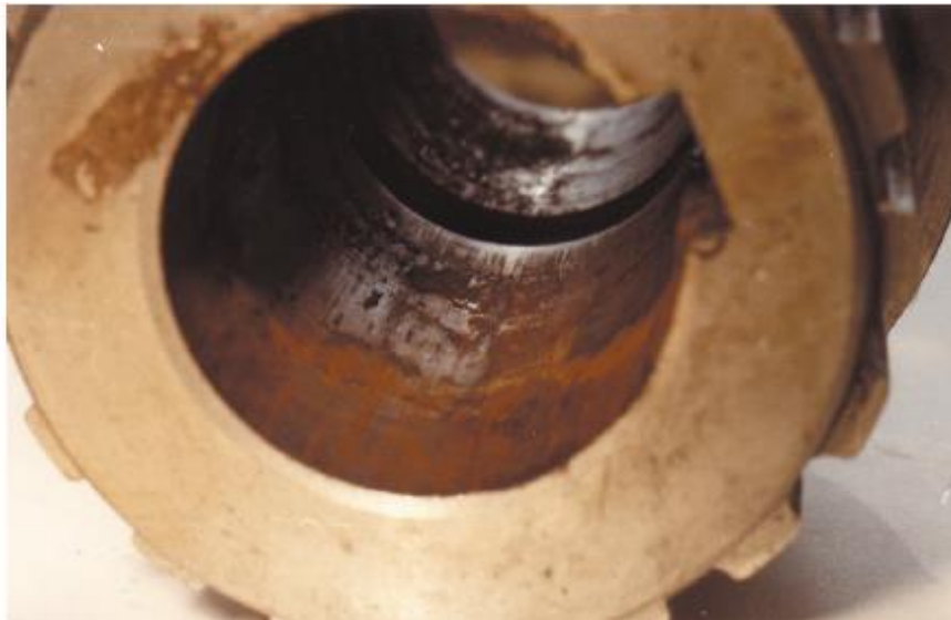
Figure III.11: Exemple de fretting-corrosion. Douille d'assemblage en acier.
