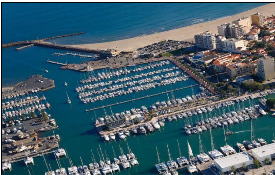
Figure I.01 Exemple d'un port de plaisance
