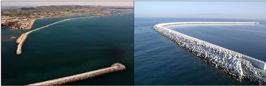
Figure I.04 Exemples des digues maritimes
