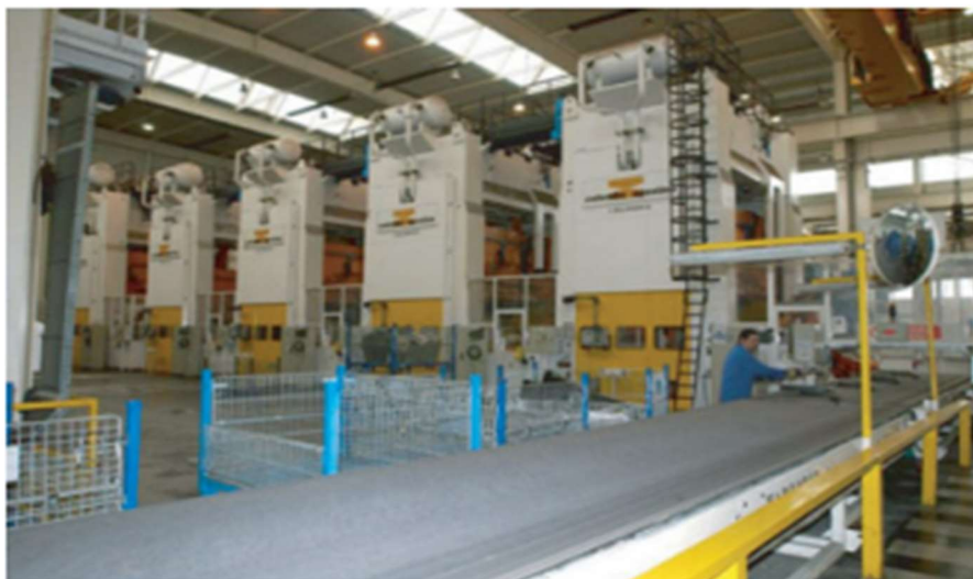
Figure II.14 : Ligne de presse tandem.
