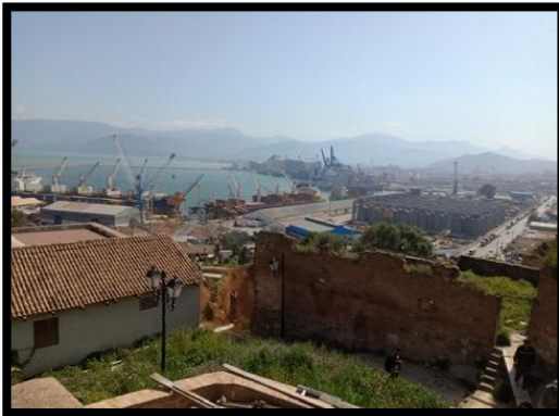
Photos II-41: La casbah en cours de réhabilitation Source : Auteurs 2019
