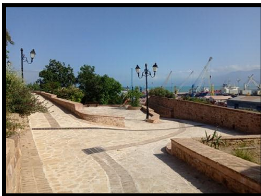
Photos II-42: La casbah en cours de réhabilitation Source : Auteurs 2019
