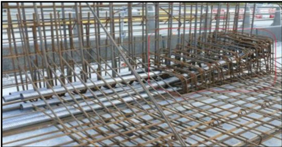
*Figure VIII-21 : ferrailage d'un bossage dans un voussoir*
