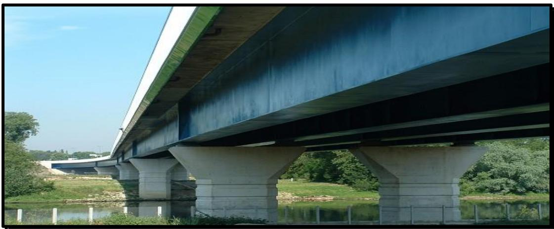
**Figure II-2 : Pont mixte à poutres multiples.**
