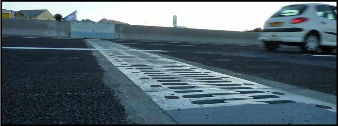
***Figure X-8 : Photo réelle d'un joint de chaussée***
