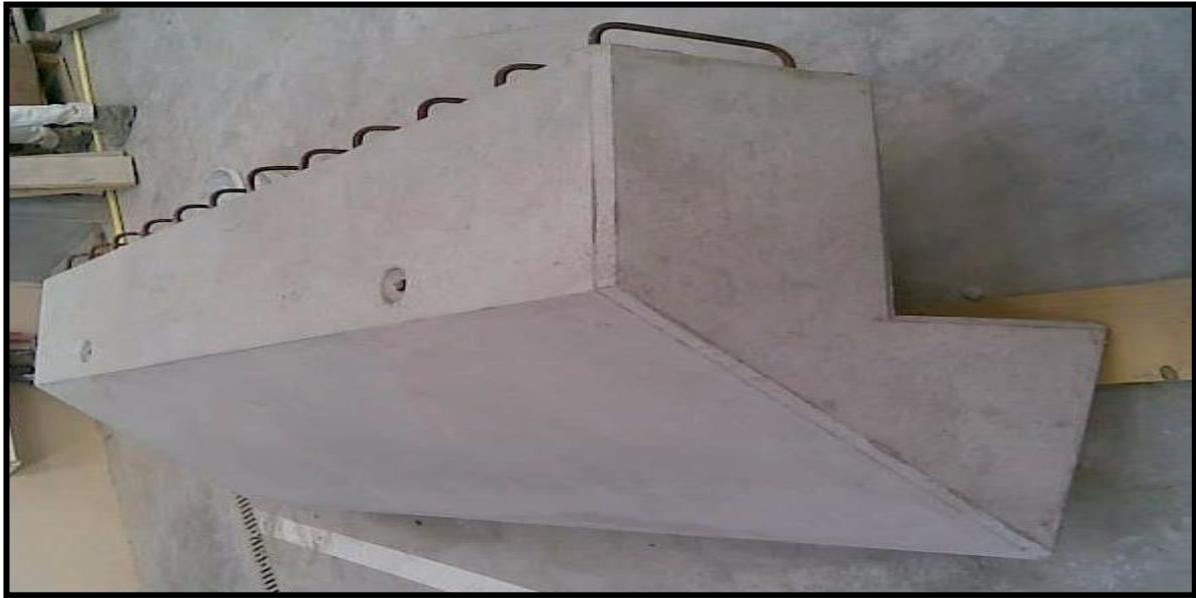
***Figure X-13 : photo Corniches préfabriquées sur chantier.***
