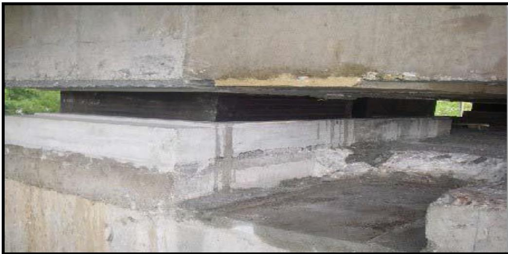
**Figure X-1: Appareil d'appui en élastomère fretté.**
