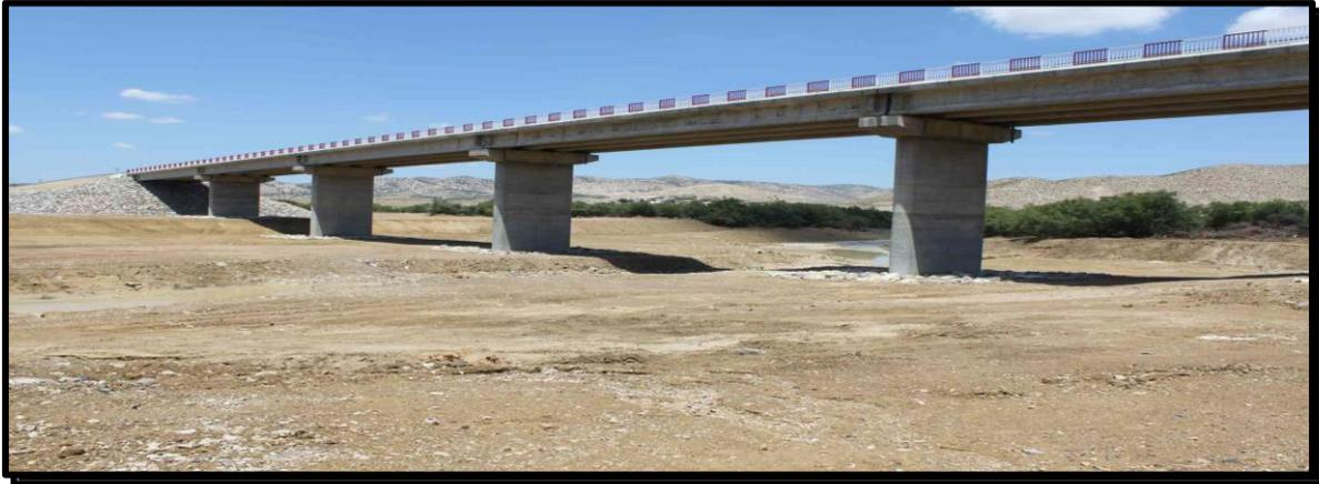
*Figure II-1 : Pont à poutres multiples en béton précontraint.*
