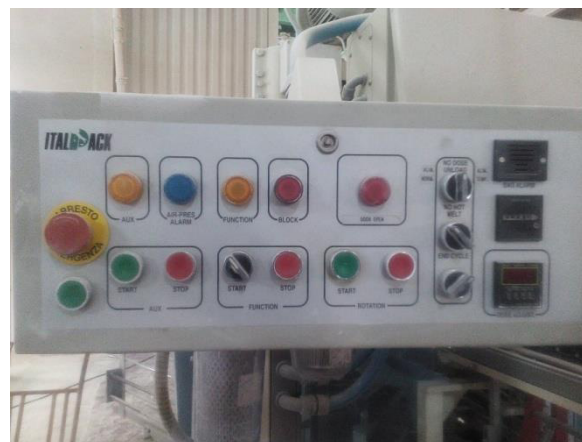
Figure I.30 : boîtiers de commande.
