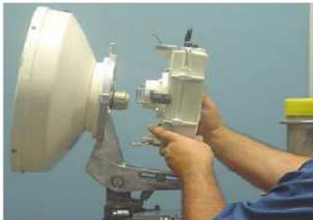
Fig.30. montage de l'antenne
