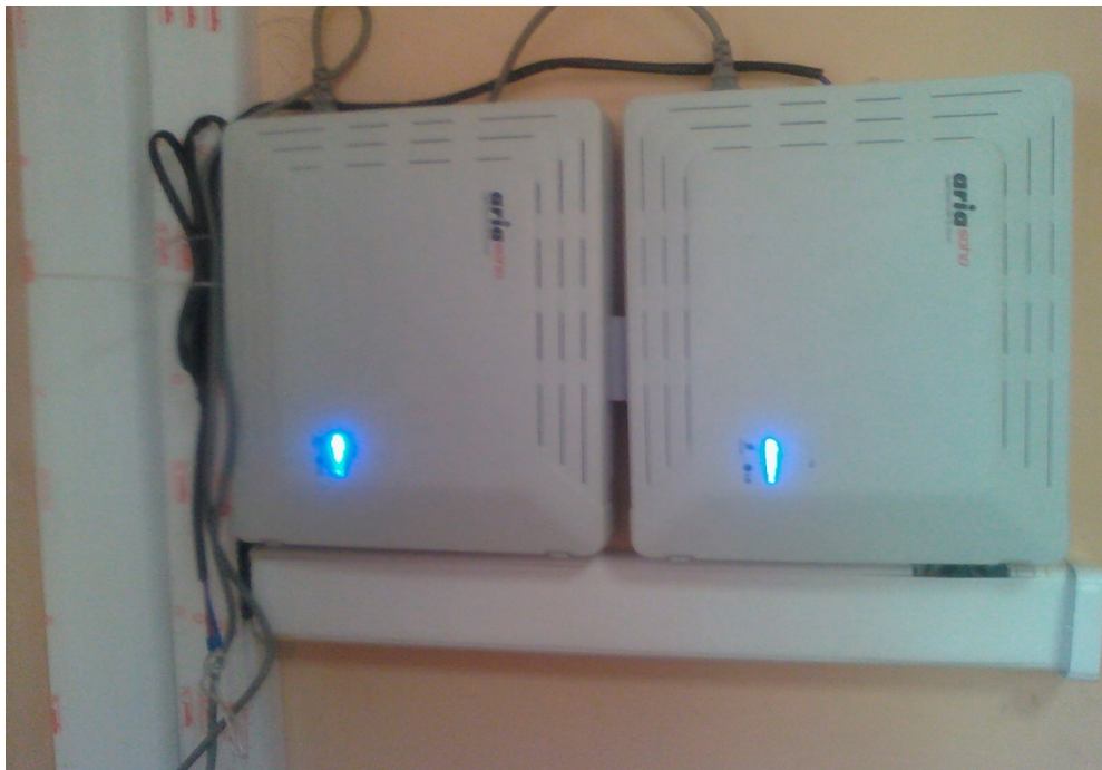
Fig. 64. Installation du standard et de son extension
