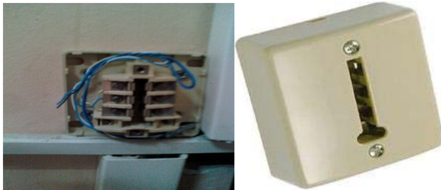
Fig. 58. Branchement des prises téléphoniques
