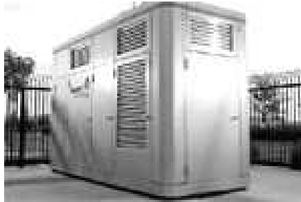
Figure (I.3) : Module de génération de l'hydrogène par l'électrolyse de l'eau [1].
