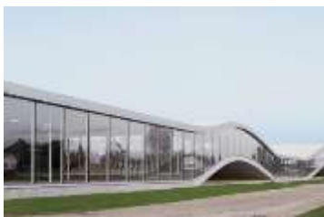
Figure 114 : 2ème accès sud. Source : www.architecturalrecord.com
