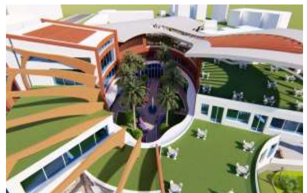
Figure 195 : façades intérieures du patio central. Source : auteurs.
