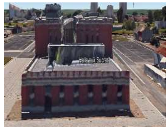
Figure 157 : Façade Nord Source : Google Earth
