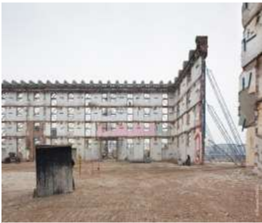
Figure 160 : La halle en pleins travaux Source : www.halleauxsucres.fr
