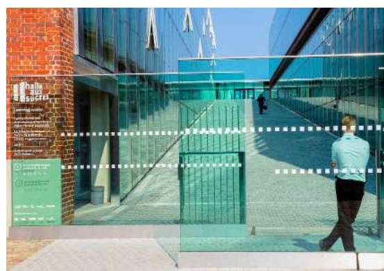
Figure 164 : Entrée principale de la halle Source : www.halleauxsucres.fr
