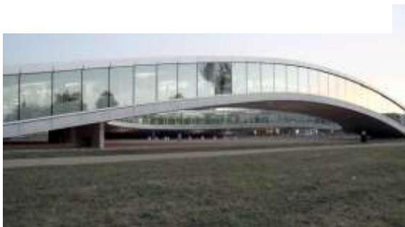
Figure 126 : Vue sur la façade principale. Source : www.2019.architectes.ch
