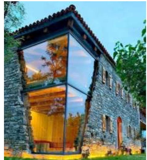
Figure 248 : façade déchirée en pierre.
