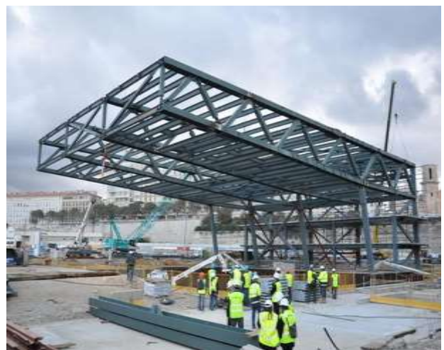
Figure 249 : Structure d'un port à faux.
