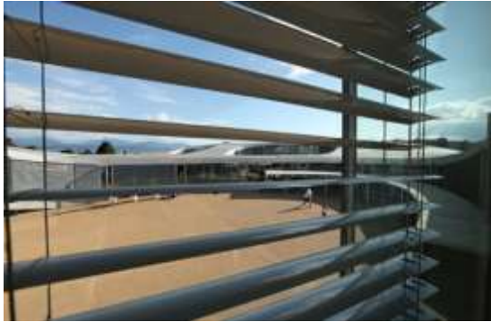
Figure 124 : Stores à lames mobiles (brise soleil). Source : www.projets.batidoc.ch
