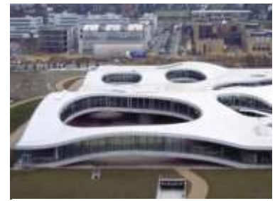
Figure 116 : accès parking et piéton à l'est. Source : www.bollinger-grohmann.com
