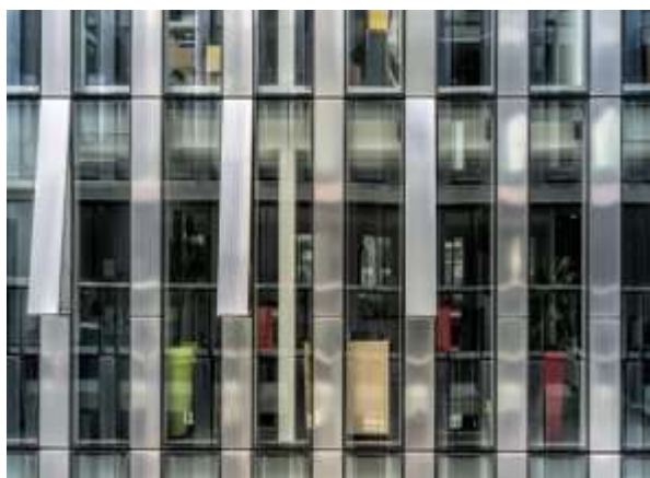
Figure 163 : Façade à triple vitrage Source : www.halleauxsucres.fr
