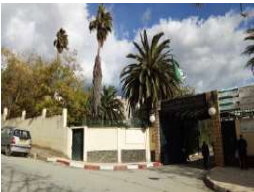
Figure 42 : 1ère entrée au sud. Source : auteurs.
