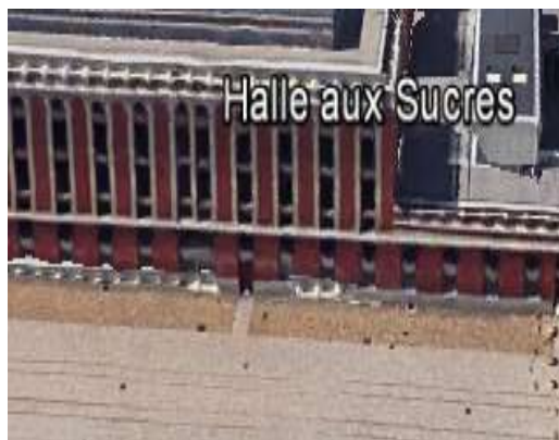
Figure 158 : Façade Est Source : Google Earth
